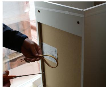
Monter remsene i overkant og nedre kant. Fire stk pr. skap. For høyskap del fire remser og fordel jevnt på hver side på bakside skap.
