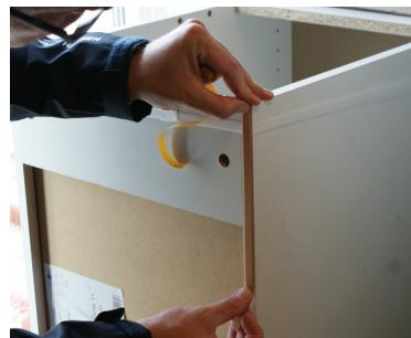
Den kappede silikonslangen har dimensjon 12/6 x 19 mm. Hvis det halvborrede hullet er større ( hvis det finnes ) må det borres opp nye hull med diameter 13 mm. En del skap har feste både opp og nede. Benkeskapet på bildet har bare to fester.
